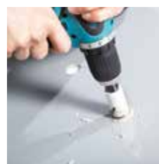
4. Durchgänge bohren und entgraten
