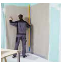
1. Wandflächen nach Vorschrift vorbereiten
